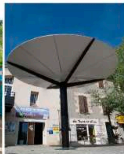
Structure métallique d'ombrière photovoltaïque
