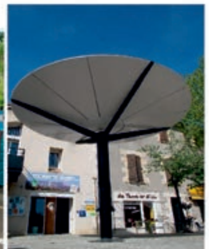
Structure métallique d'ombrière photovoltaïque
