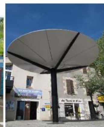
Structure métallique d'ombrière photovoltaïque
